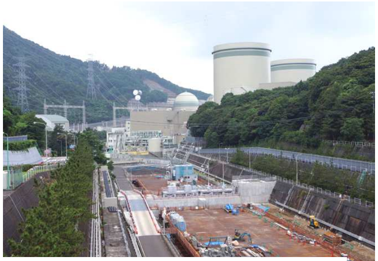
写真は高浜原発。手前の工事は津波対策のための新しく作られる防波堤。(2014年8月撮影)
