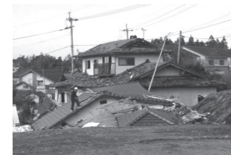
崩れたままの家屋
