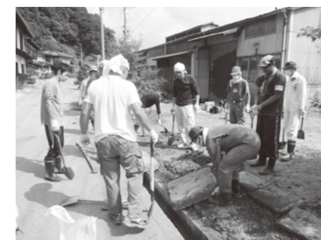
京都府舞鶴市：泥の撤去作業
