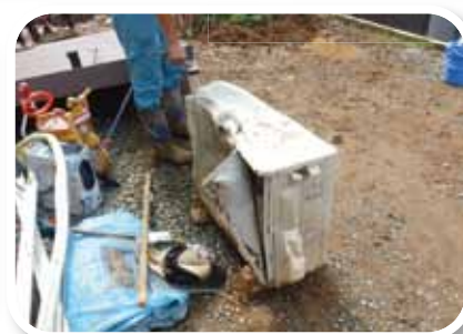
▲土砂で形が崩れた室外機
